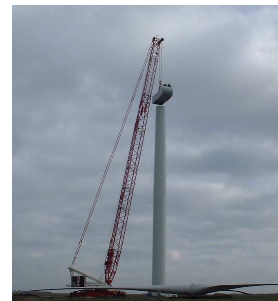
Montage de la nacelle
