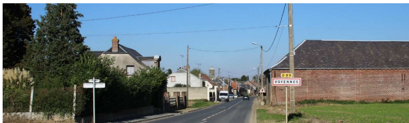
Le village de Voyennes s'est organisé au carrefour de la RD 417 qui longe le fond de vallée et la RD 89 qui traverse perpendiculairement pour relier les deux plateaux agricoles.
